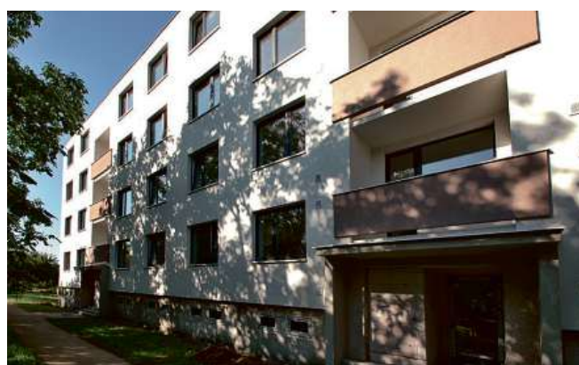
Investiční byty v zrekonstruovaném domě v Brně-Chrlicích.
