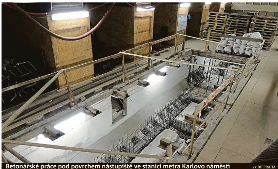
Betonářské práce pod povrchem nástupiště ve stanici metra Karlovo náměstí
