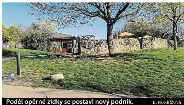
Podél opěrné zidky se postaví nový podnik. D. MOKŘÍŽOVÁ
