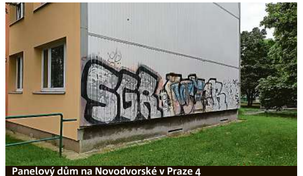
Panelový dům na Novodvorské v Praze 4
