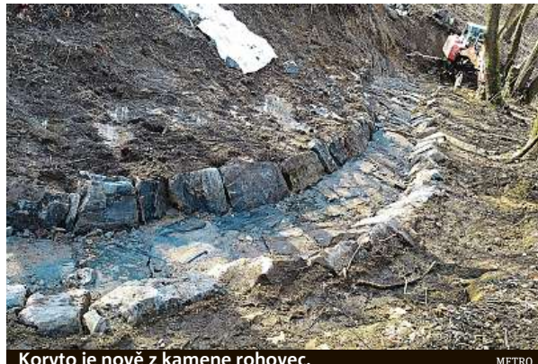
Koryto je nově z kamene rohovec.
