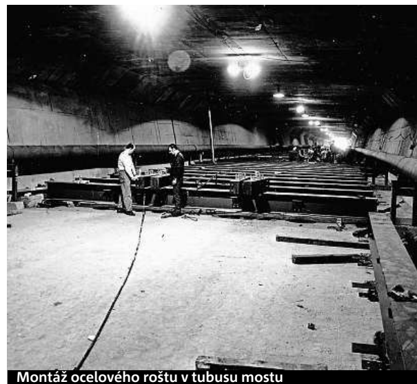
Montáž ocelového roštu v tubusu mostu
