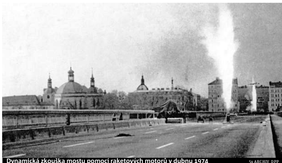
Dynamická zkouška mostu pomocí raketových motorů v dubnu 1974
