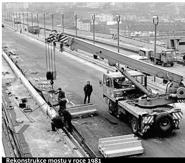
Rekonstrukce mostu v roce 1981
