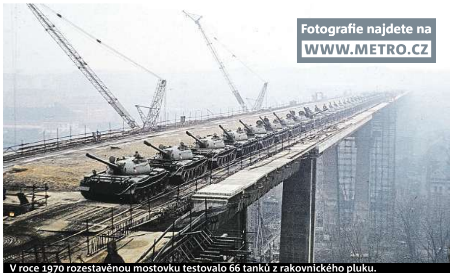
V roce 1970 rozestavěnou mostovku testovalo 66 tanků z rakovníckého pluku.
