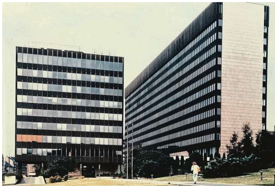
Legendární budova Chemapol Investa mezi léty 1966 a 1970, pohled z Kavkazské ulice. Jejimi autorkami jsou Zdenka M. Nováková a Dagmar Šestáková. NÁRODNÍ GALERIE V PRAZE
