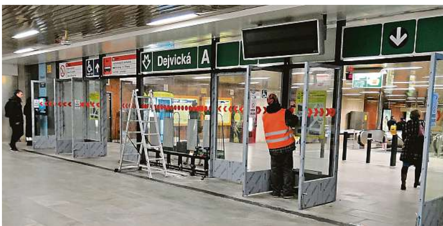
Práce na Dejvické se nezastavily už na podzim, jak měl dopravce původně v plánu.
