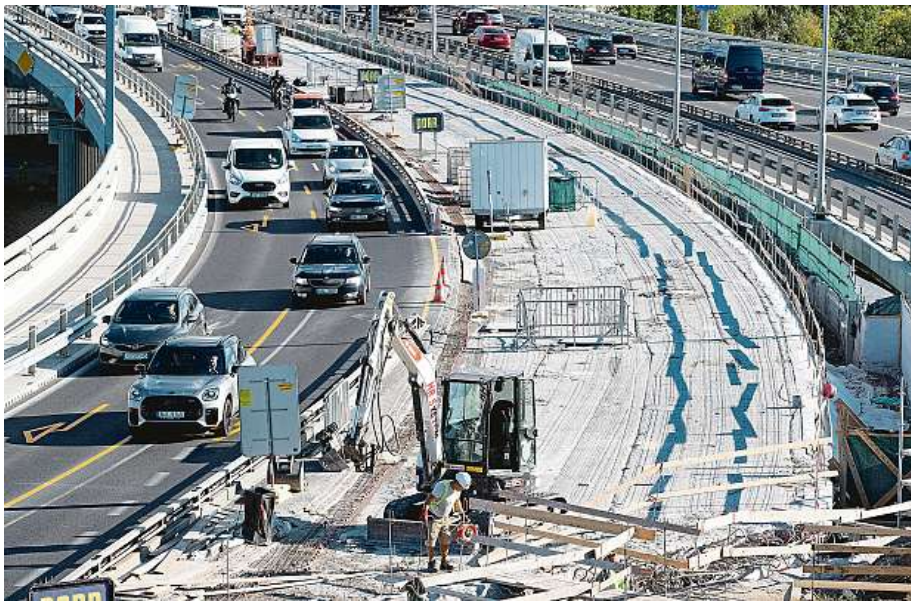
Oprava Barrandovského mostu začala v roce 2022.
