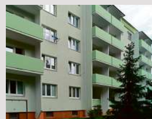
→ Realizace přistavěných lodžií - prodloužení původních lodžií
