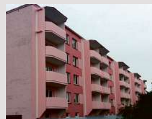
→ Realizace přistavěných lodžií - náhrada balkonů lodžiemí
