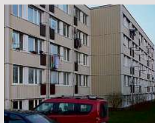
Původní stav bytového domu - francouzská okna bez balkonů
