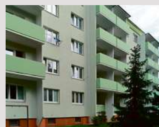
→ Realizace přistavěných lodžií - prodloužení původních lodžií
