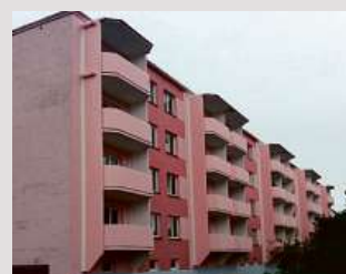
→ Realizace přistavěných lodžií - náhrada balkonů lodžiemi
