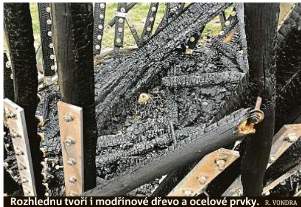
Rozhlednu tvoří i modřínové dřevo a ocelové prvky. R. VONDRA
