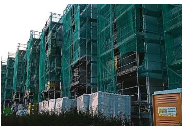
Ochranné sítě na lešení při opravě fasád nebo zateplování nejsou jen estetická záležitost. Brání šíření prachu do okolí. METRO
