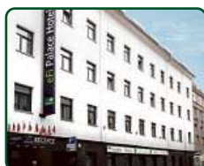
eFi Palace Hotel, Brno, dokončené 2 etapy
