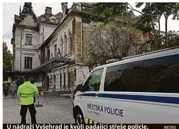
U nádraží Vyšehrad je kvůli padající střeše policie. METRO
