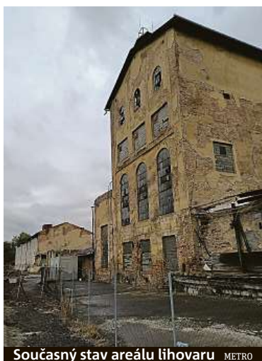
Současný stav areálu lihovaru METRO
