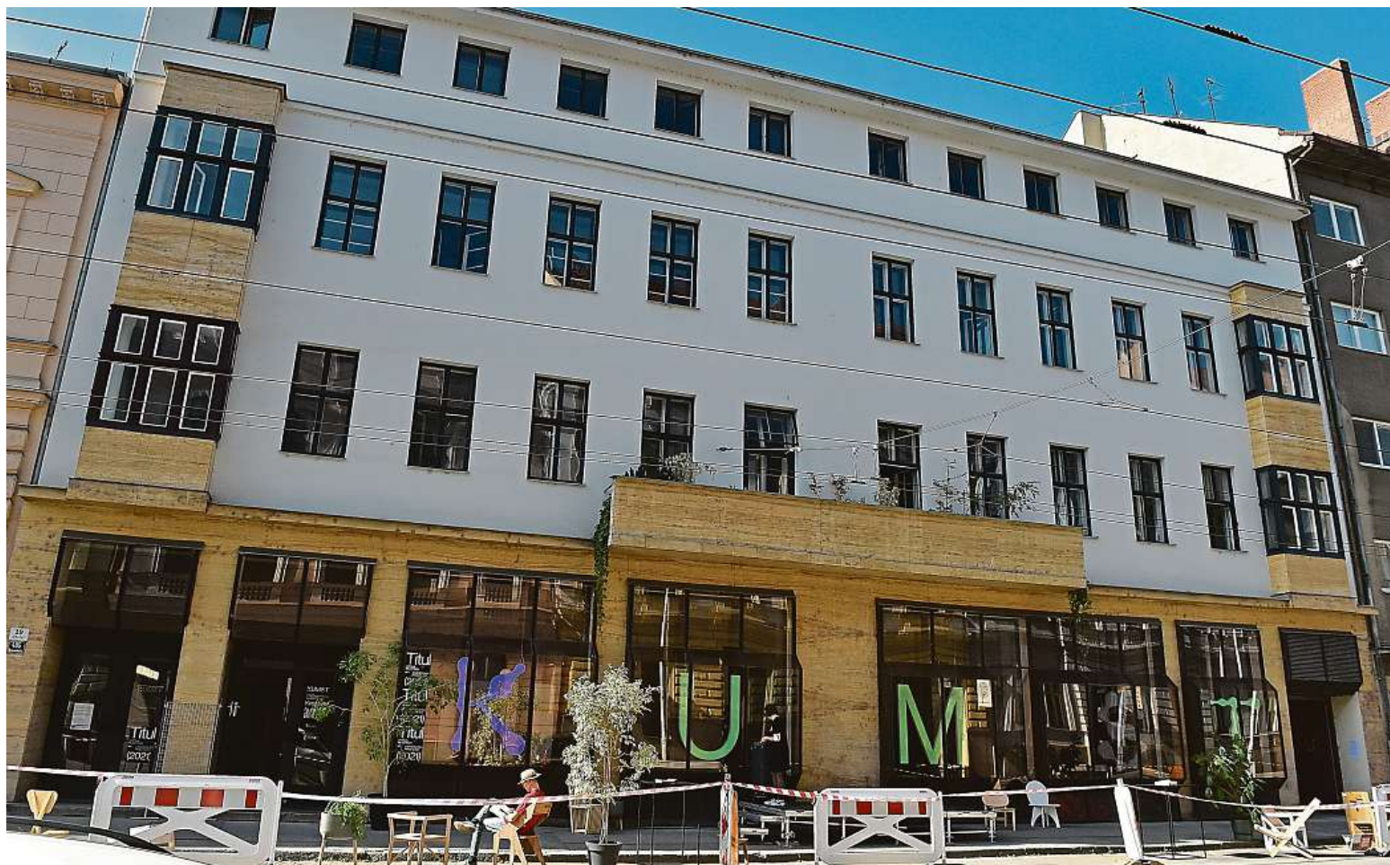
Budovu v Údolní ulici, která patří Vysokému učení technickému, má Kumst pronajatou na osm let s opcí.
