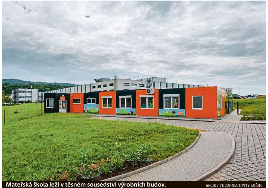
Mateřská škola leží v těsném sousedství výrobních budov.
