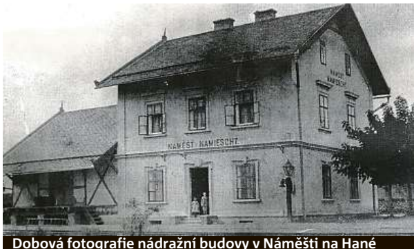
Dobová fotografie nádražní budovy v Náměšti na Hané
