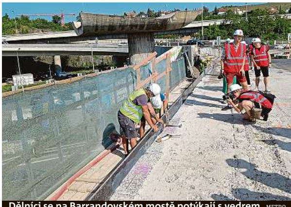
Dělníci se na Barrandovském mostě potýkají s vedrem. METRO
