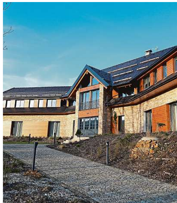
Novostavba domu na Šumavě
