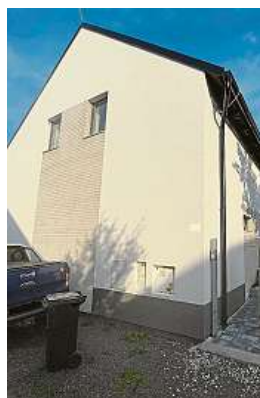
Dokončovací práce rodinného domu
