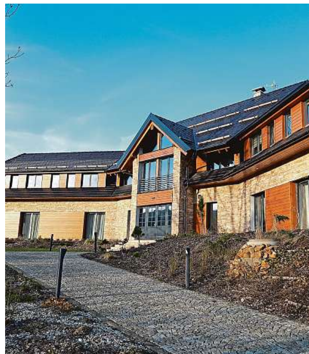
Novostavba domu na Šumavě
