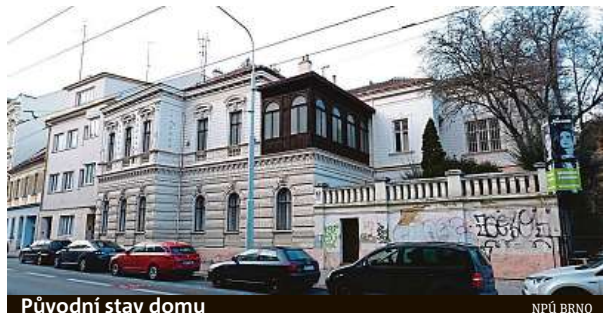
Původní stav domu
