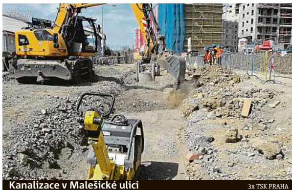
Kanalizace v Malešické ulici
