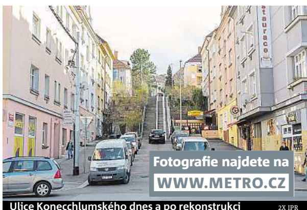
Ulice Konecchlumského dnes a po rekonstrukci
