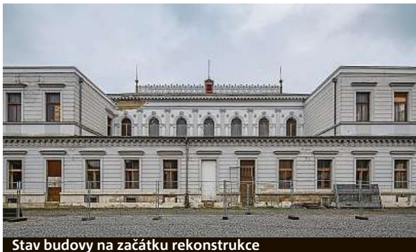
Stav budovy na začátku rekonstrukce
