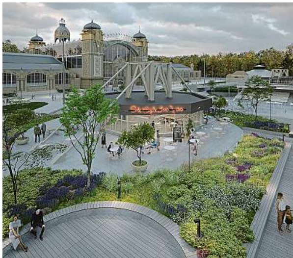
Oprav se dočká i Křížikova fontána a střechy přilehlých pavilonů. To už bude Průmyslový palác (v pozadí) v novém. VÝSTAVIŠTĚ PRAHA A. S.
