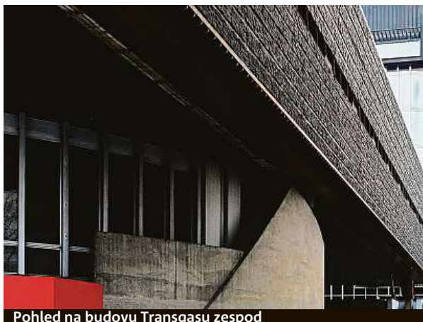
Pohled na budovu Transgasu zespod
