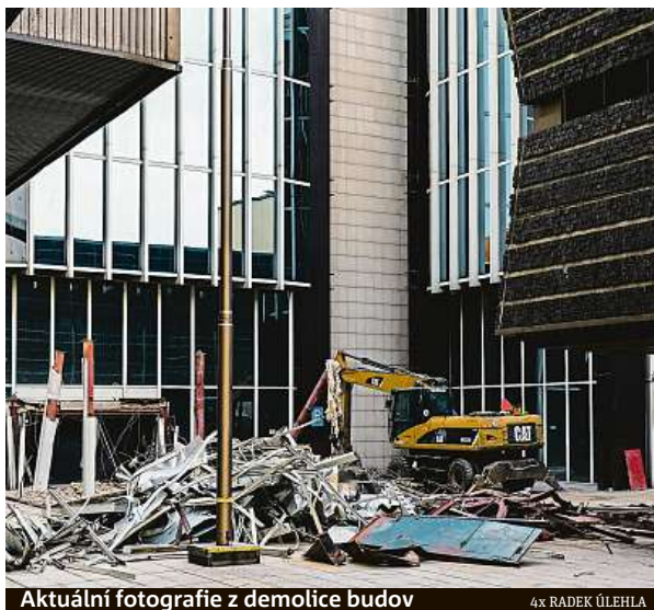
Aktuální fotografie z demolice budov
