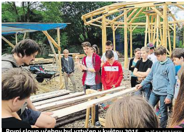
První sloup učebny byl vztyčen v květnu 2015. 2x ZŠ NA BERÁNKU
