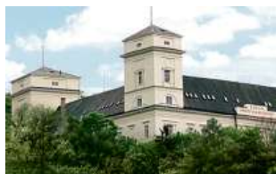
Zámek Račice, přestavba
