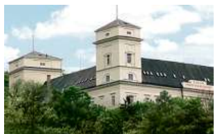
Zámek Račice, přestavba
