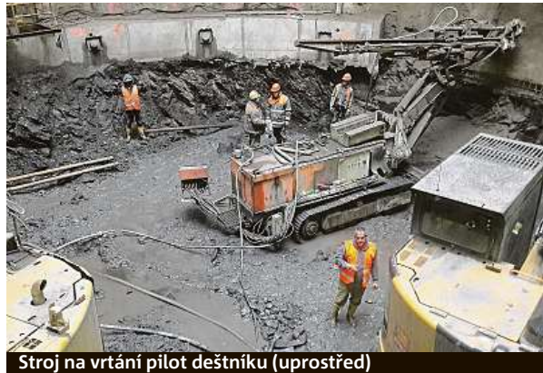
Stroj na vrtání pilot dešťníku (uprostřed)
