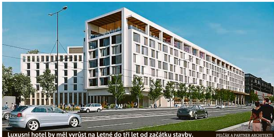
Luxusní hotel by měl vyrůst na Letné do tří let od začátku stavby.
