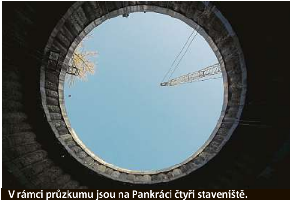
V rámci průzkumu jsou na Pankráči čtyři staveniště.
