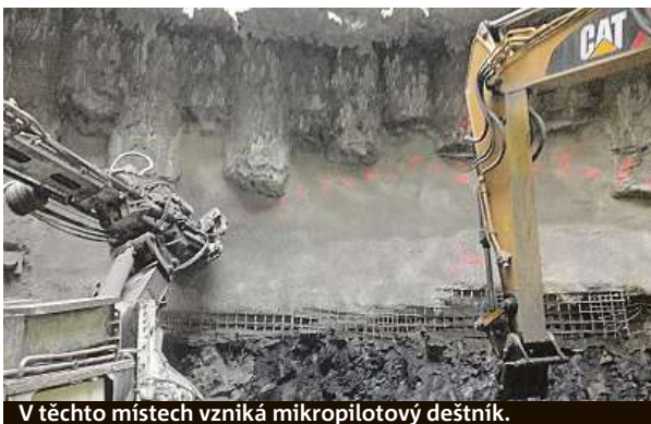
V těchto místech vzniká mikropilotový dešťník.
