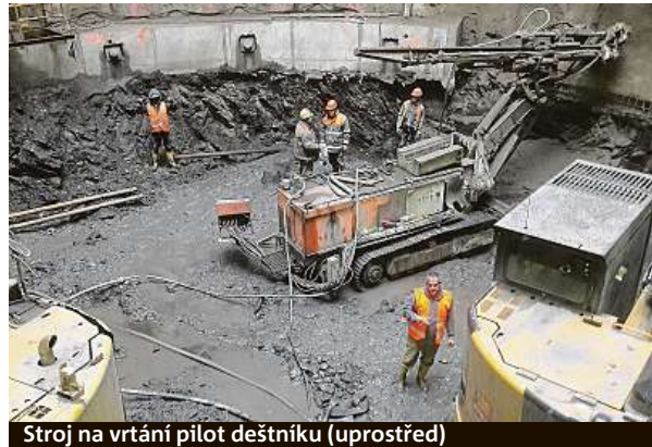
Stroj na vrtání pilot dešťníku (uprostřed)
