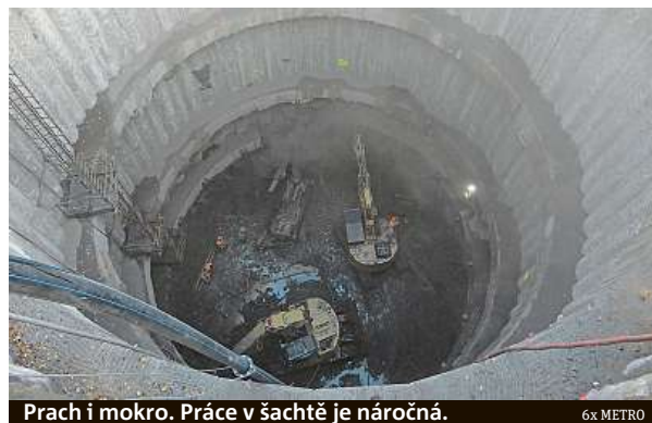
Prach i mokro. Práce v šachtě je náročná.
