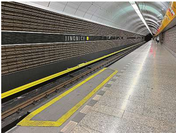
Překážkou pro vozíčkáře je mezera mezi hranou nástupiště a vagonem. Ta je nezbytná pro boční výkyvy vozů, daný jejich odpružením a zatížením. Proto začal před lety dopravní podnik do stanic instalovat rampy k prvnímu a gumové přechody k poslednímu vagonu.
