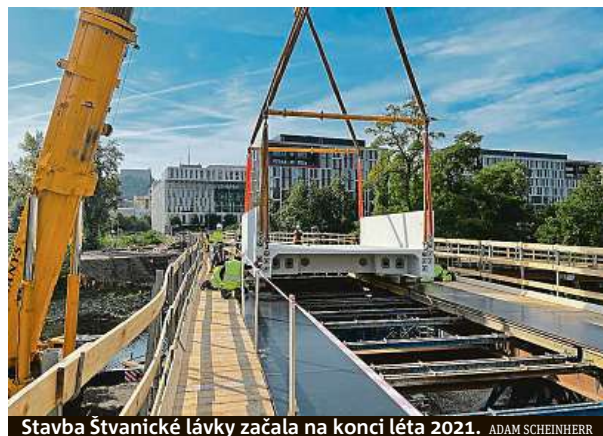
Stavba Štvanické lávky začala na konci léta 2021.
