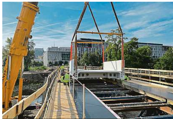
Stavba Štvanické lávky začala na konci léta 2021.
