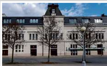
Multifunkční budova, Brno
