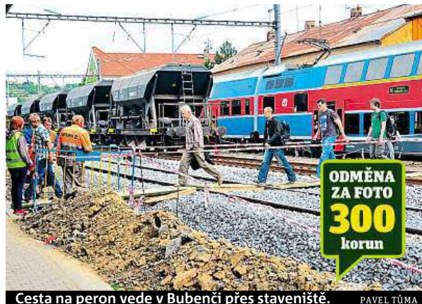
Cesta na peron vede v Bubenči přes staveniště. PAVEL TŮMA
