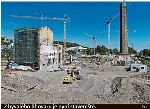
Z bývalého lihovaru je nyní staveniště.
