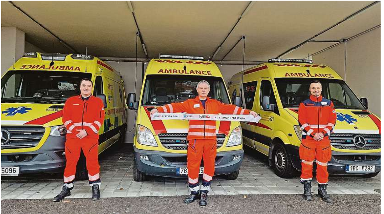
V Kyjově nyní slouží přibližně dvacítká záchranářů. V nové základně získali více prostoru pro garáže sanitek. Budova je navíc energeticky úspornější než podobné starší objekty.
