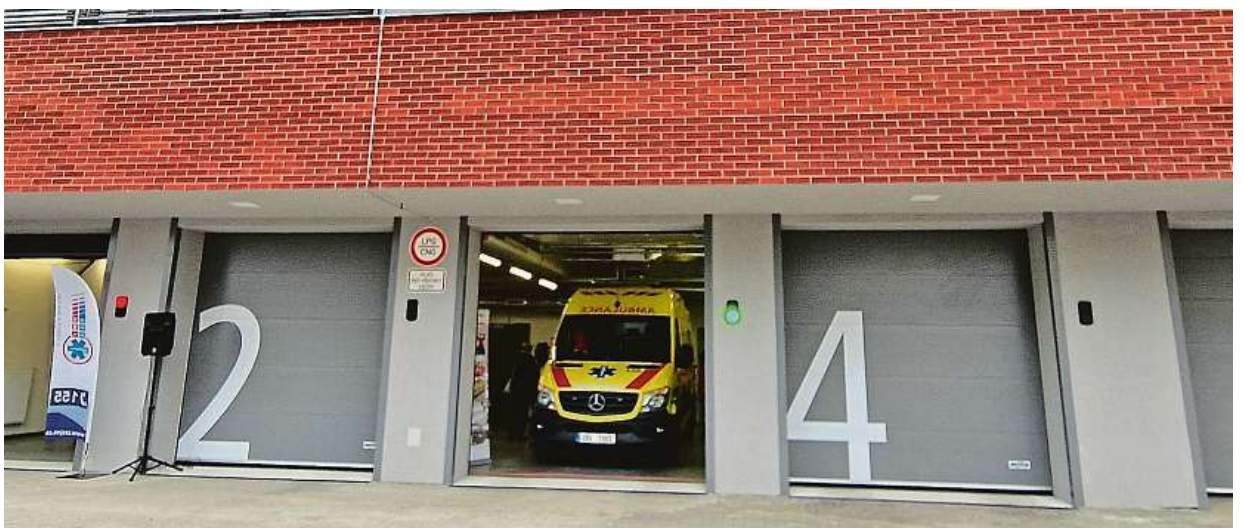
Nová základna záchrané služby v Kyjově vyšla na 180 milionů korun. Kromě toho, že poskytuje kvalitní a moderní zázemí zdravotníkům, stavba samotná se bude ucházet o titul jihomoravské stavby roku.
