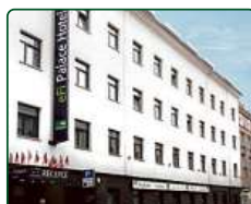
eFi Palace Hotel, Brno, dokončené 2 etapy
