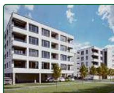
Bytové domy Břeclav, ul. Charvátská
