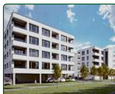
Bytové domy Břeclav, ul. Charvátská
