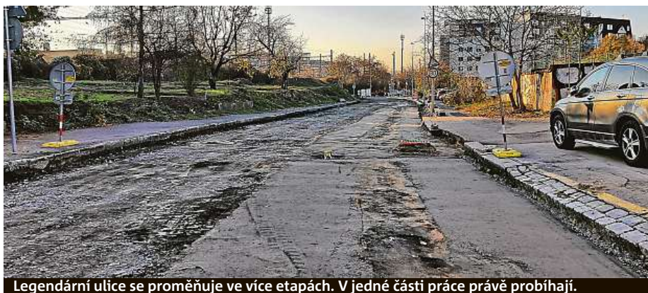
Legendární ulice se proměňuje ve více etapách. V jedné části práce právě probíhají.
