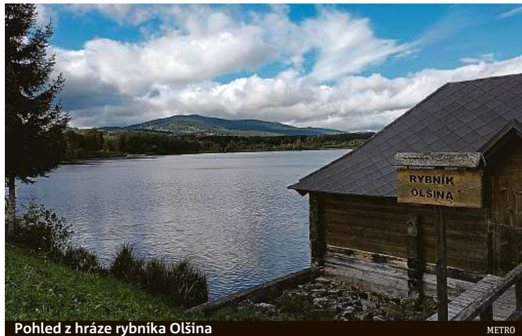
Pohled z hráze rybníka Olšina
