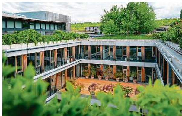
Zelené střechy s promenádami, stromy a lavičkami zkrášlují, ale také ochlazují budovy pražské centrály ČSOB.
