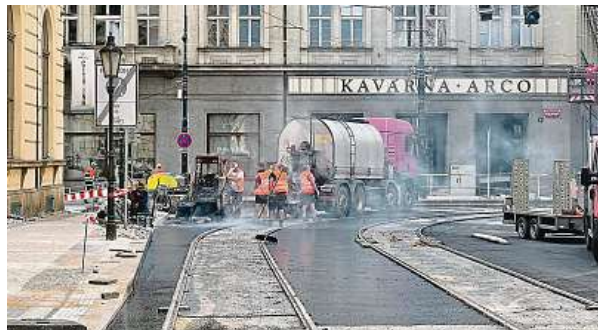
Pracovníci dopravního podniku, Pražské vodohospodářské společnosti i Pražské plynárenské distribuce sebou mrskli. DPP
