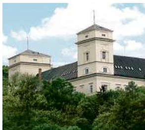
Zámek Račice, přestavba
