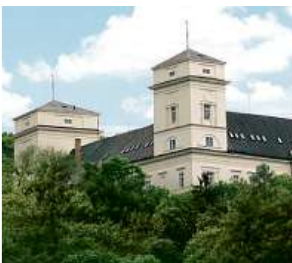
Zámek Račice, přestavba
