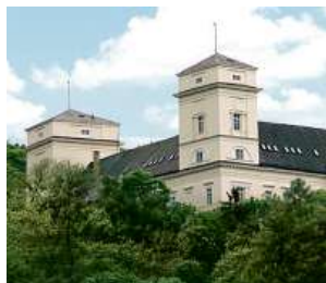
Zámek Račice, přestavba
